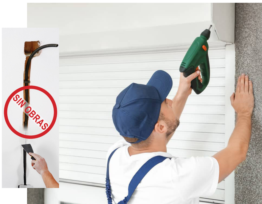
instalación de una persiana nueva sin preocupaciones por la electricidad
